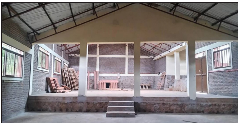
Construction de l'internat à l'Ecole Fondamentale de Kivoga au Burundi
