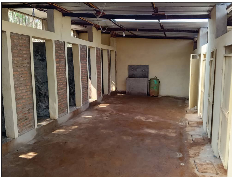
La construction des sanitaires pour l'internat de Kivoga au Burundi
