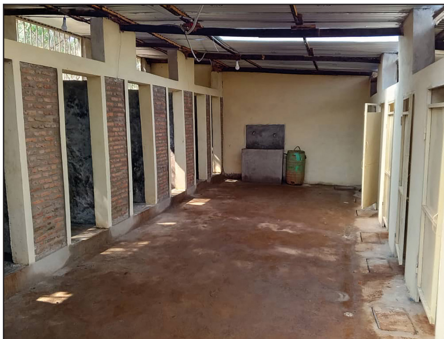
De bouw van de sanitaire voorzieningen voor het internaat van Kivoga in Burundi
