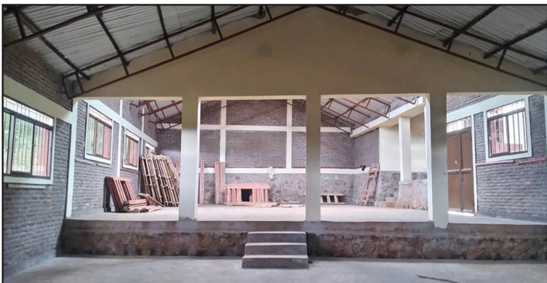
Bouw van het internaat van de Basisschool van Kivoga in Burundi
