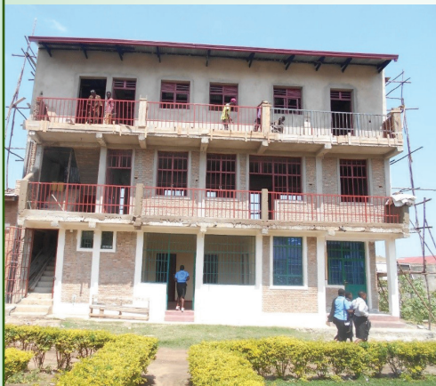
LES TRAVAUX CONTINUENT
