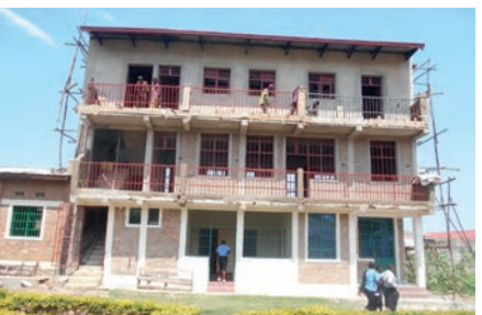
les travaux continuent
